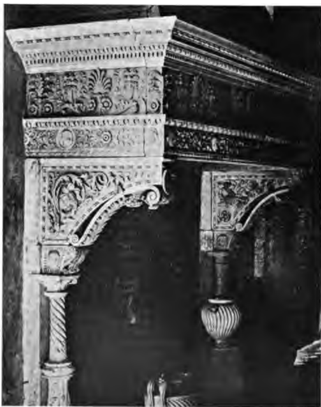
Fig. 125. — Cheminée au Palais Ducal de Venise. Corbeaux saillants sur les piédroits pour le soutien du linteau.
